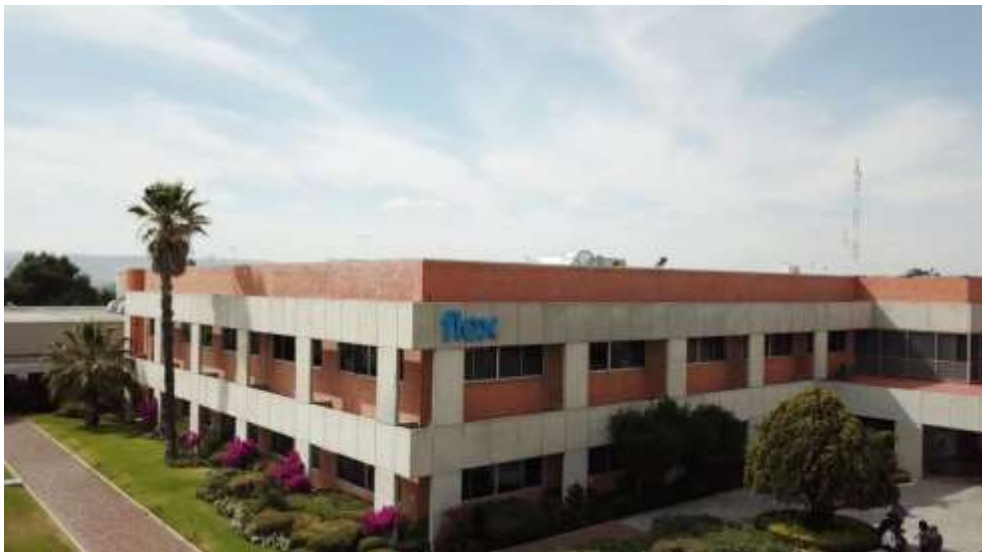
Figura 1. Instalación de Flex. Fuente: Flex Aguascalientes S.A De C.V 2022.
